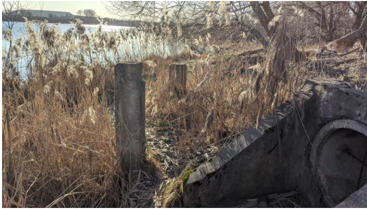
Рис. 4.6. Выпуск в водохранилище из ливневого коллектора Ø900мм
