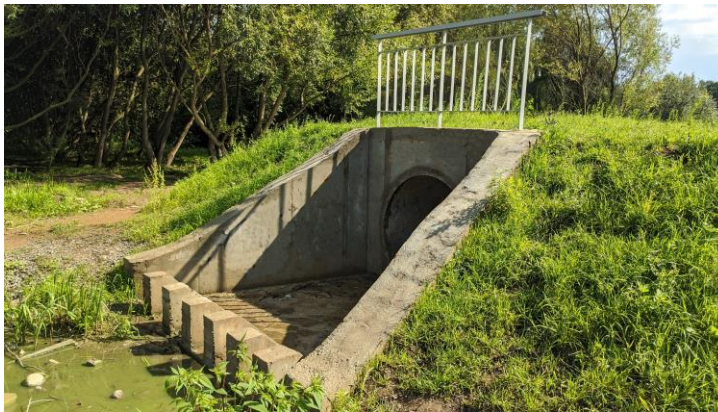
Рис. 4.7. Оголовок выпуска на ливневом коллекторе Ø1200мм
