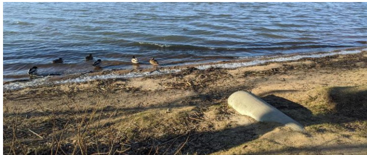
Рис 4.9. Выпуск Ø300мм из дождеприемников в благоустроенной пешеходной зоне парка
