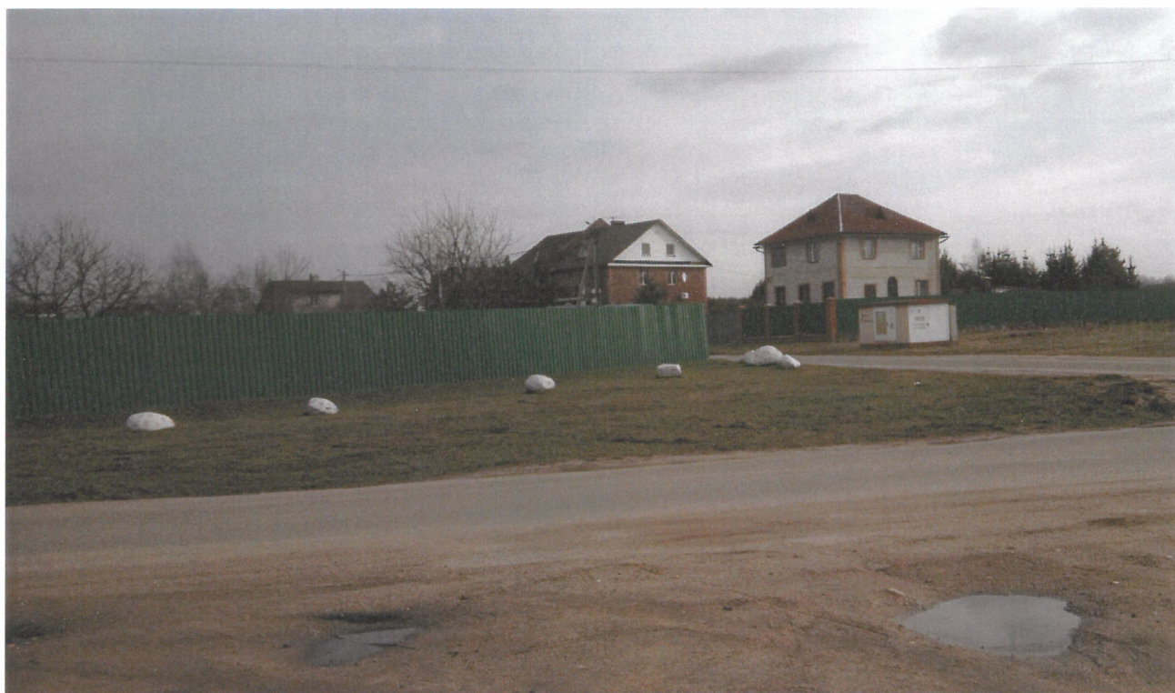
Рисунок 12 – Визуальное обследование – индивидуальной жилой застройки по ул. Новая ,2И (фото 10.03.2020г)
