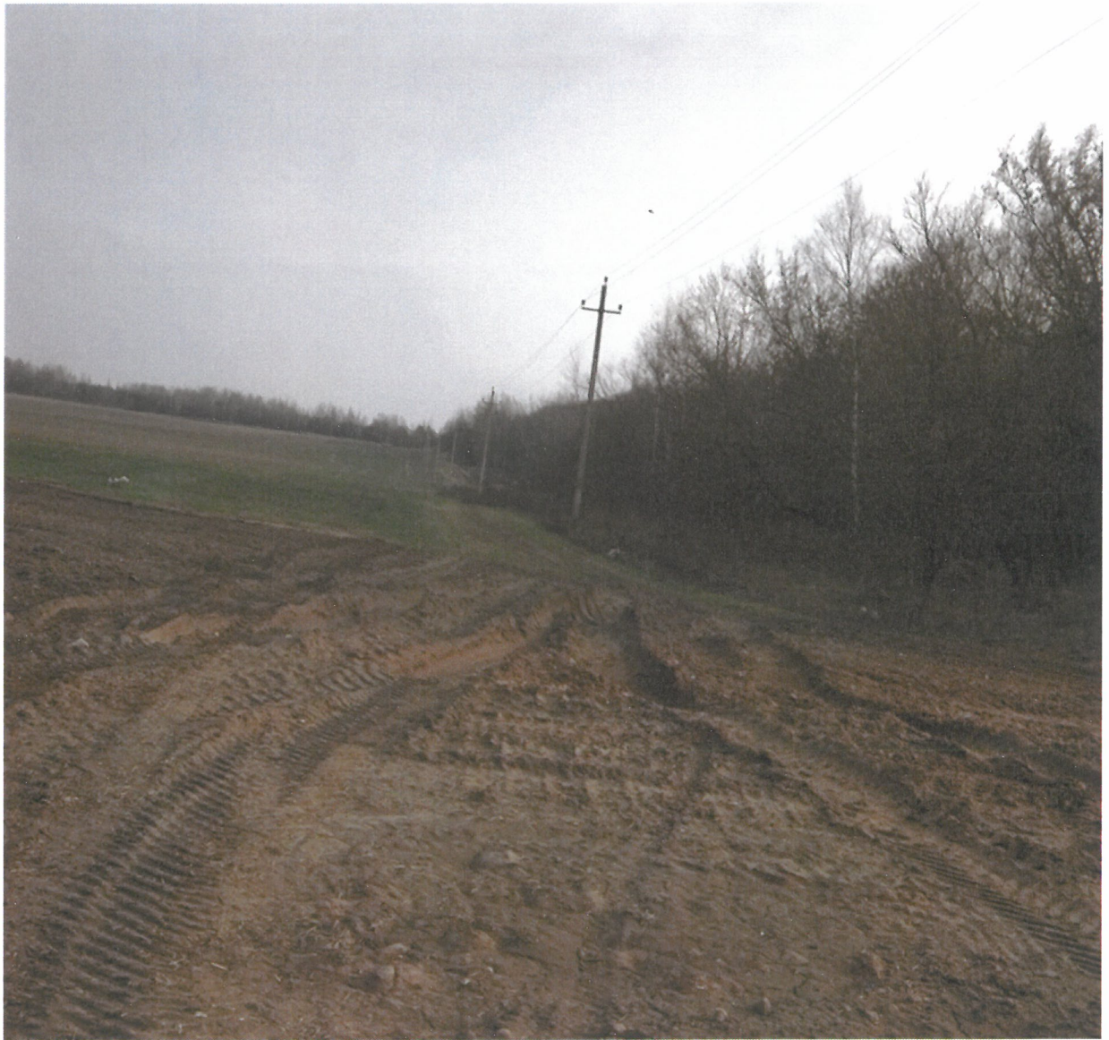
Рисунок 9 – Визуальное обследование – существующее состояние рассматриваемого объекта (10.03.2020)
