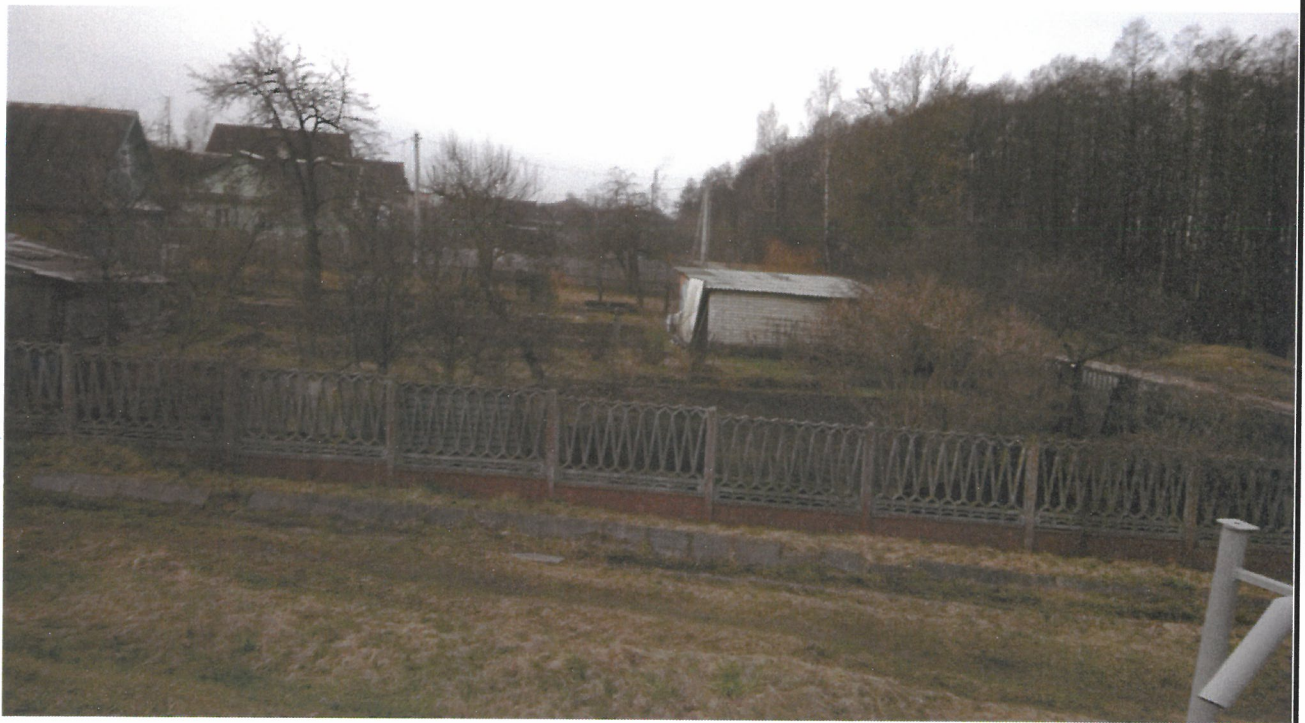
Рисунок 11 – Визуальное обследование – индивидуальной жилой застройки по ул. Заречная ,1 (фото 10.03.2020г)
