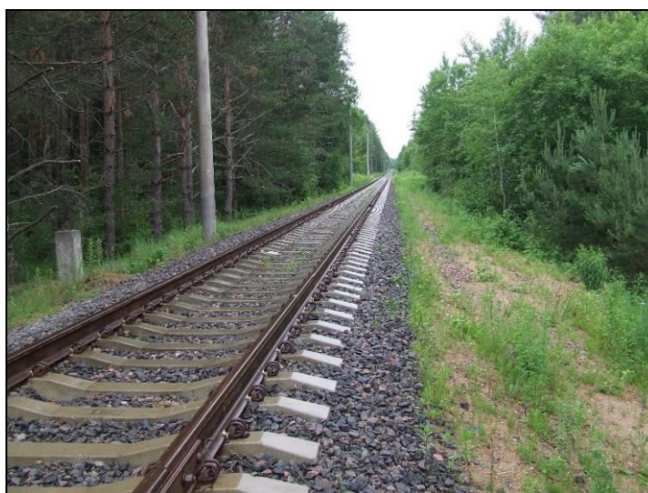
Рисунок 8 – Место пересечения трассой газопровода железной дороги
