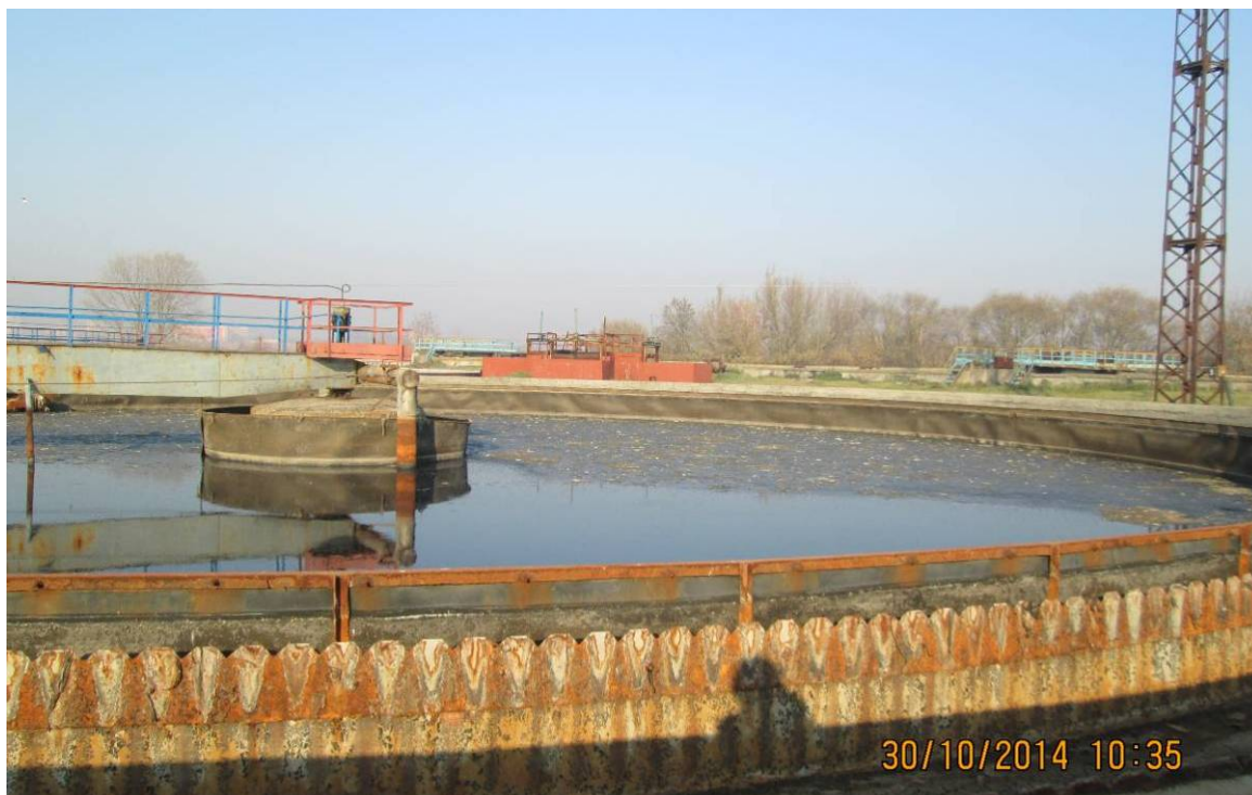
Рисунок 3. Современное состояние первичных отстойников МОС-1
